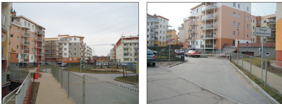
Rys. 4. Zabudowa mieszkaniowa wewnątrz osiedla zlokalizowanego u zbiegu ulic Sobieskiego i Waryńskiego
