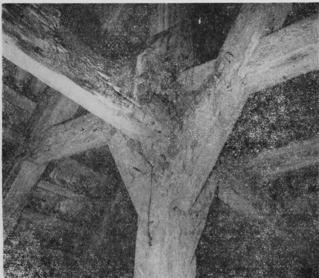
Fot. 2. Toruń — spichrz przy ul. Podmurnej nr 1. Więźba z końca XV lub początku XVI w. Część środkowa storczyka (fot. M. Orzechowski)
