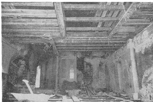
18. Kamienica „Pod Gwiazdą” — wielka sień w trakcie prac rozbiórkowych — strop antresoli po odjęciu sufitu (fot. C. Kuchta, 1967)
