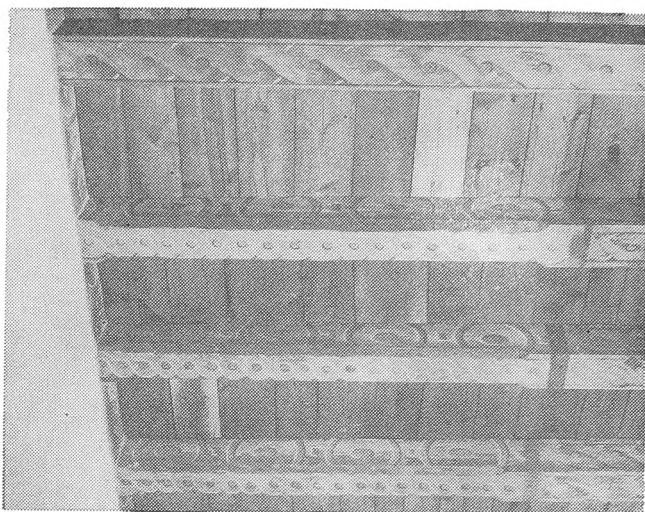
24. Kamienica „Pod Gwiazdą”. Strop w wielkiej sieni, belki z renesansową polichromią. Widoczne ślady na belkach po ścianie izdebki „wiszącej”. Na ścianie między belkami polichromowany „fryz” (fot. W. Górski, 1993)
