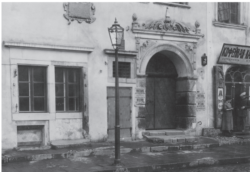
3. Fragment elewacji parteru z portalem kamienicy numer 32 (Baryczkowska) przy Rynku Starego Miasta w Warszawie. Od 1911 roku siedziba Towarzystwa Opieki nad Zabytkami Przeszłości, fot. ok. 1912, ze zbiorów MW
