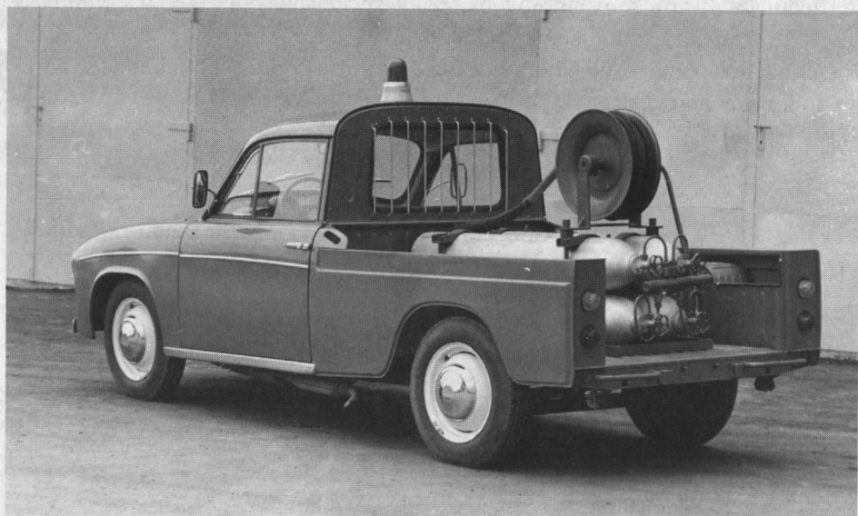
Ryc.9. Prototyp samochodu gaśniczego na bazie modelu R 20 M (1975)
