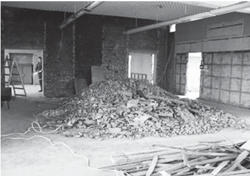
Fot. 5. Pomieszczenia biblioteczne w trakcie remontu (fot. ze zbiorów autora)
