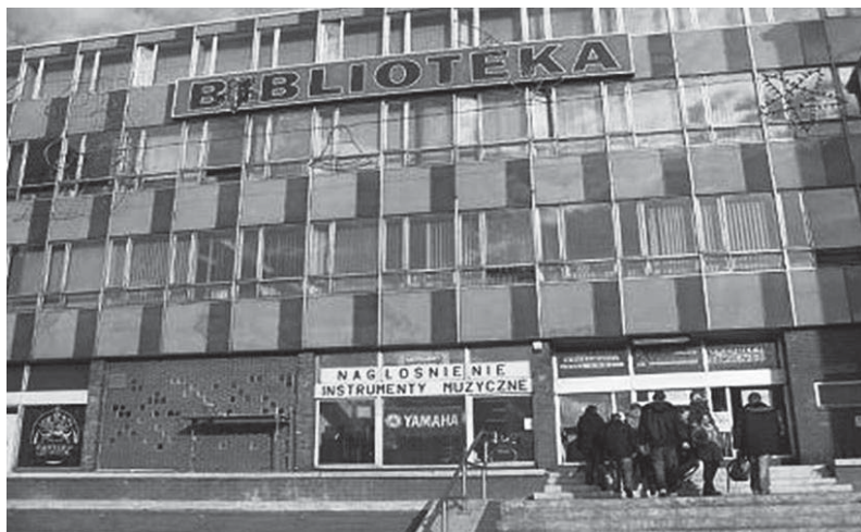
Fot. 2. Szklano-aluminiowa fasada MBP w Bytomiu przed remontem (fot. ze zbiorów autora)
