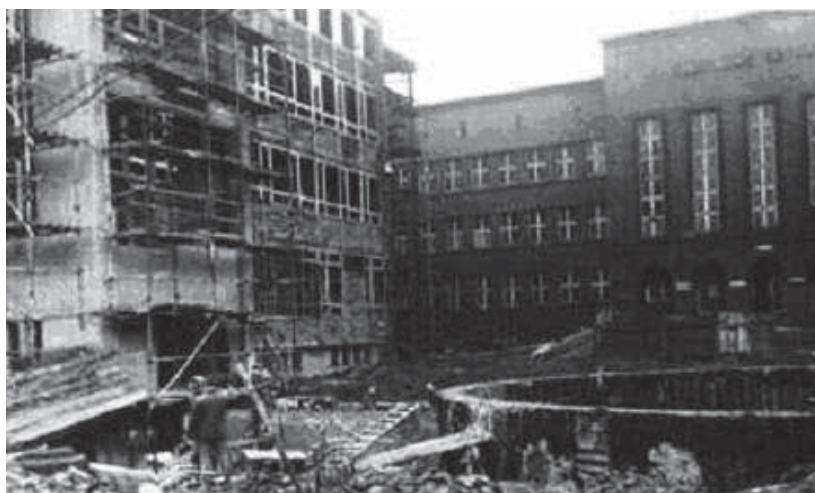
Fot 1. Budowa gmachu bytomskiej biblioteki w roku 1974 (fot. z archiwum MBP w Bytomiu)
