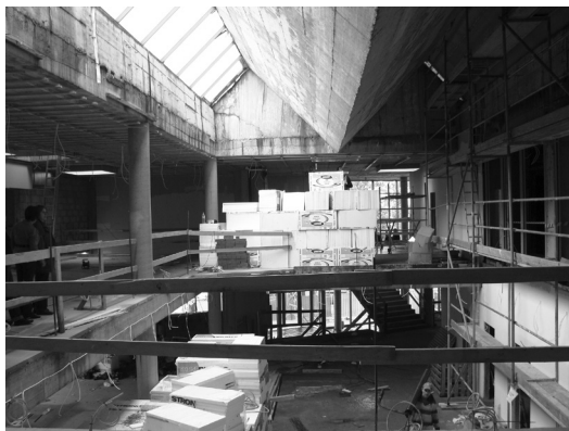
Fot. 1. Wnętrze Biblioteki podczas budowy (Fot. J. Chwałek)
