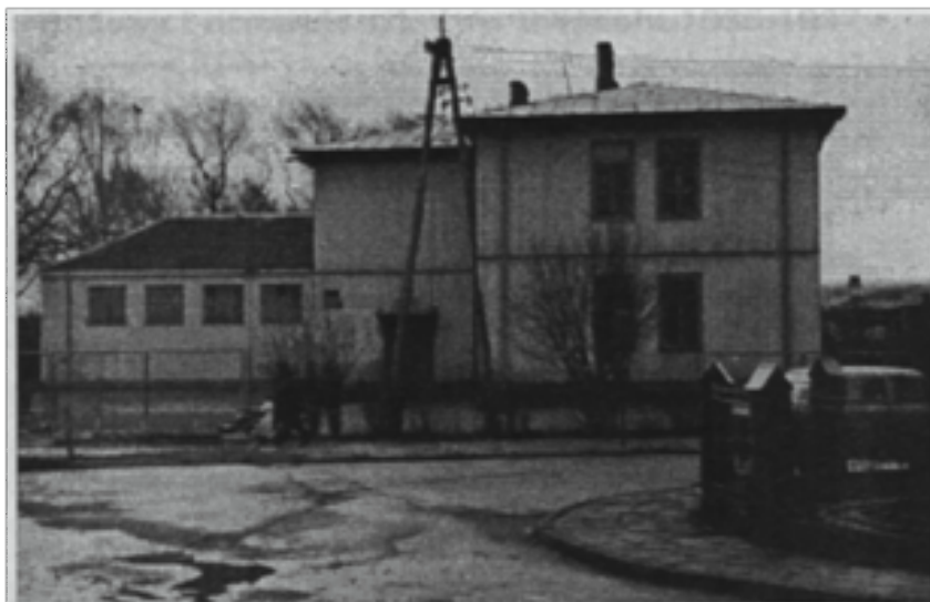
Opuszczona Szkoła w Bieżuniu. Rok 1989. Fot. St. Iłski.
