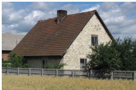
Fot. 2. Charakterystyczny budynek mieszkalny o niewielkiej powierzchni, wysokim dachu i mozaikowych murach. Wybudowano ich jedynie kilkanaście – wszystkie w gminie Uniejów Źródło: fot. autora
