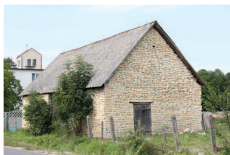
Fot. 6. Stodoła we wsi Wielenin jako przykład obiektu w całości wzniesionego z kamienia. Po lewej stronie widoczny fragment wieży kościoła Źródło: fot. autora
