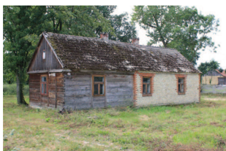
Fot. 4. Budynek o konstrukcji mieszanej, częściowo wzniesiony z drewna, częściowo murowany z opok (wieś Wielenin) Źródło: fot. autora
