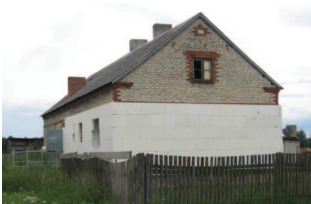
Fot. 11–12. Coraz częściej jednak tradycyjny materiał jest ukrywany pod warstwą ocieplenia i tynku Źródło: fot. autora
