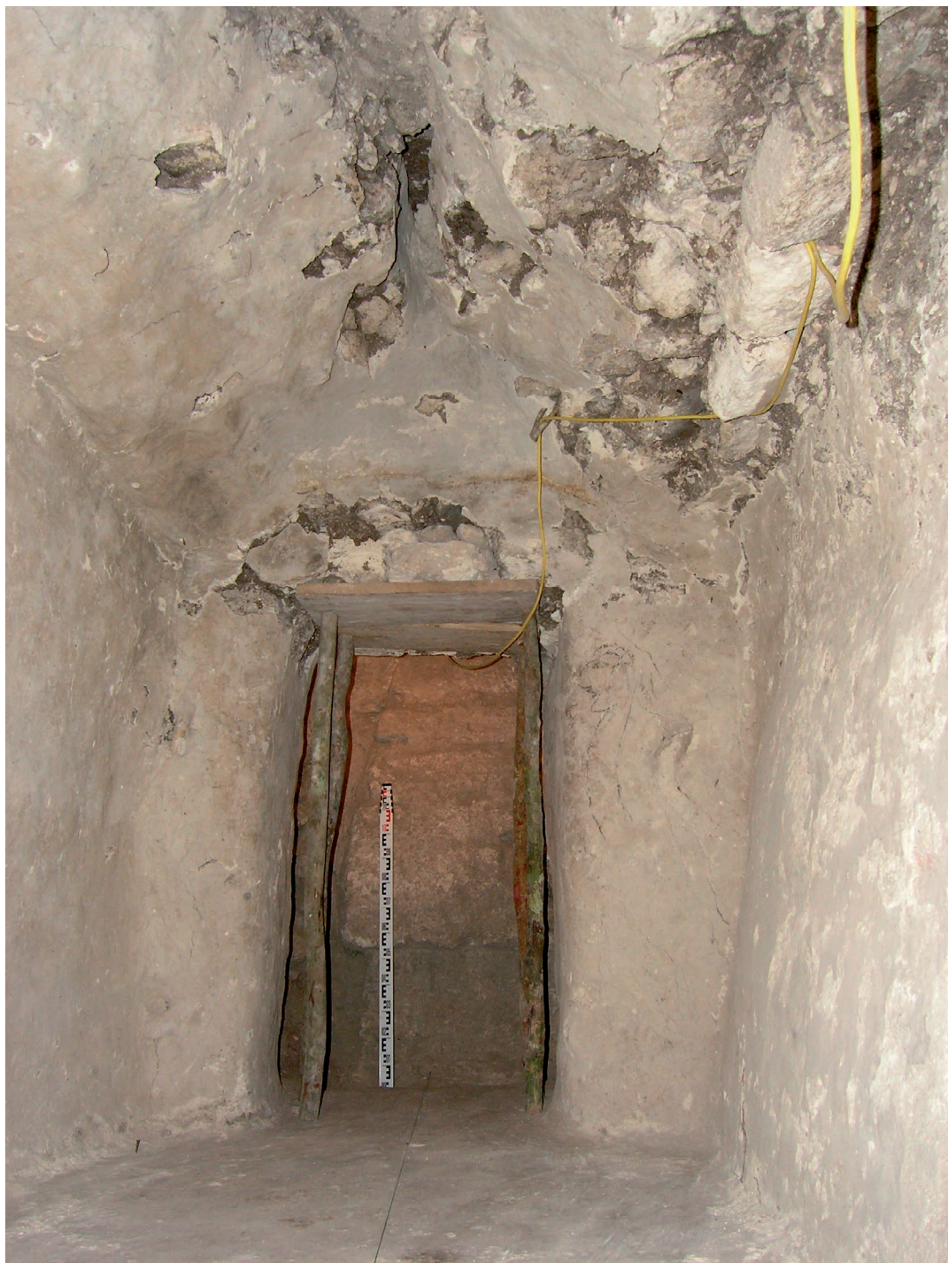
Fig 49. Parte norte de la Cámara 3, Edificio 14.
