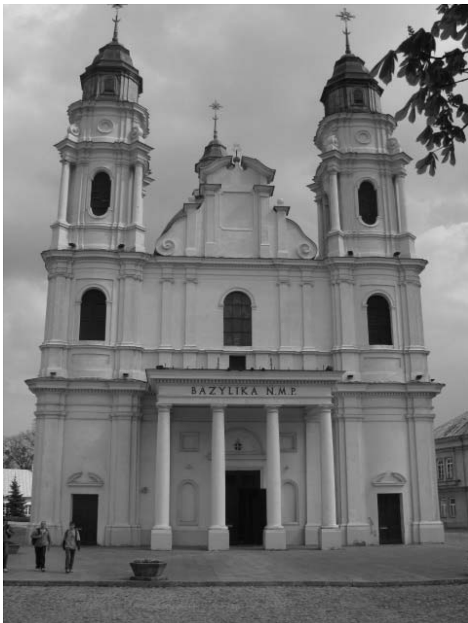
Rys. 4. Rzymskokatolicka bazylika Narodzenia NMP w Chełmie (wcześniej cerkiew) jest przykładem połączenia stylów architektonicznych i dekoratorskich. W nawie głównej świątyni znajduje się bizantyjska ikona, a wieże kościelne wieńczą cebulaste prawosławne hełmy
