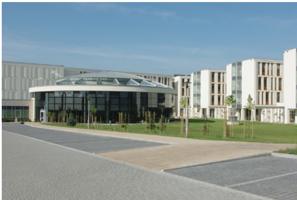
Biblioteka i budynek Wydziału Zarządzania i Komunikacji Społecznej UJ (fot. Dawid Bittner)
