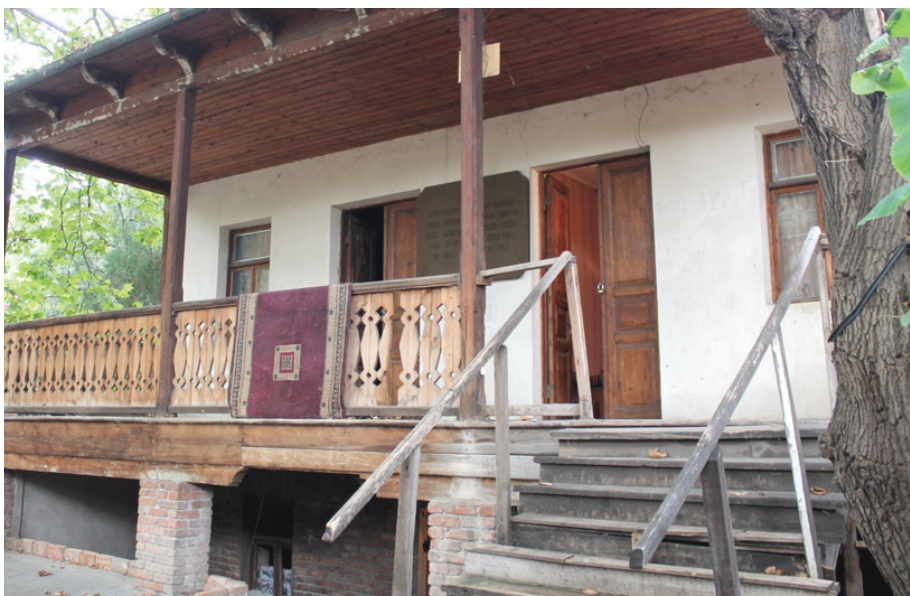
Dom, pod którym znajduje się nielegalna piwnica. © Autor: B. Krzysztań
