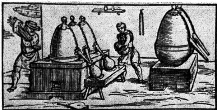
Rys. 3. Destylacja rtęci. Z dzieła V. Biringuccia Pirotechnia (1540)
