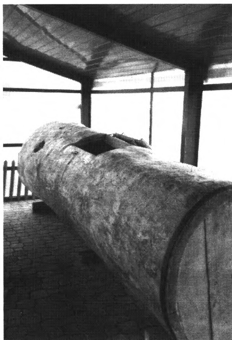
Ryc. 10. „Elewator” zbożowy wydłubany w pniu dębowym – przykład ludowej myśli technicznej. Fot. autor.
