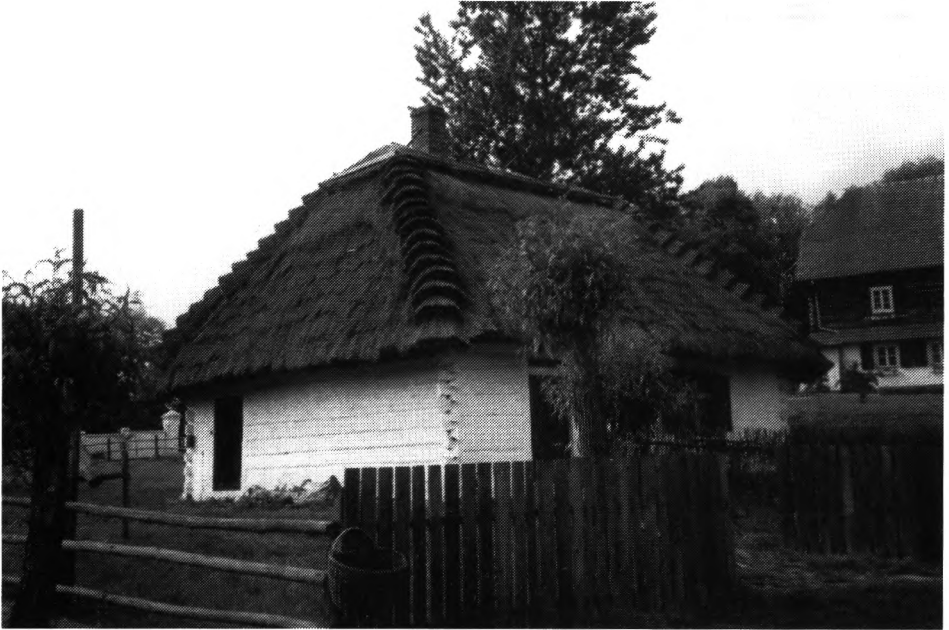
Ryc. 3. Zagroda poleska z przykładami różnych typów ogrodzeń: od lewej – płot belkowy, sztachetowy, w głębi wiklinowy. Fot. autor.
