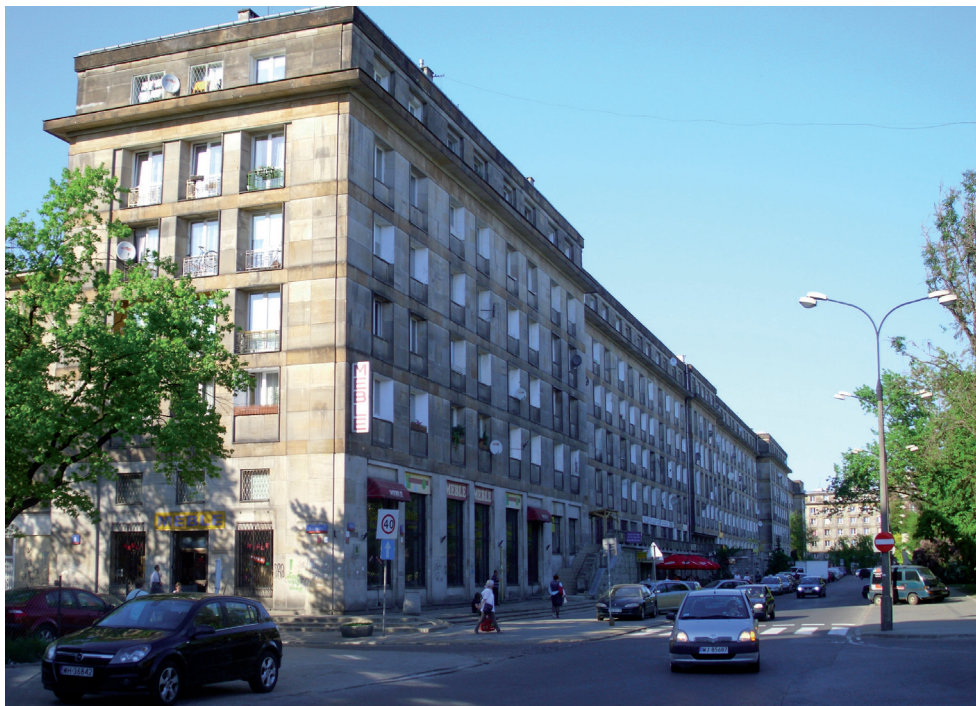
Ryc. 2. Osiedle Praga II, jeden z budynków okalających plac Hallera – wyraźnie widać podział elewacji na cokół, bryłę główną i zwieńczenie
