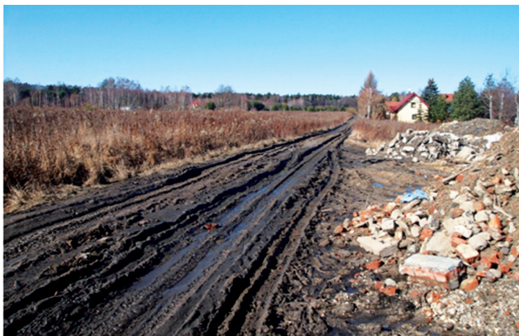
Fot. 4. Polna droga dojazdowa do nowych posesji wybudowanych w „szczerym polu”
