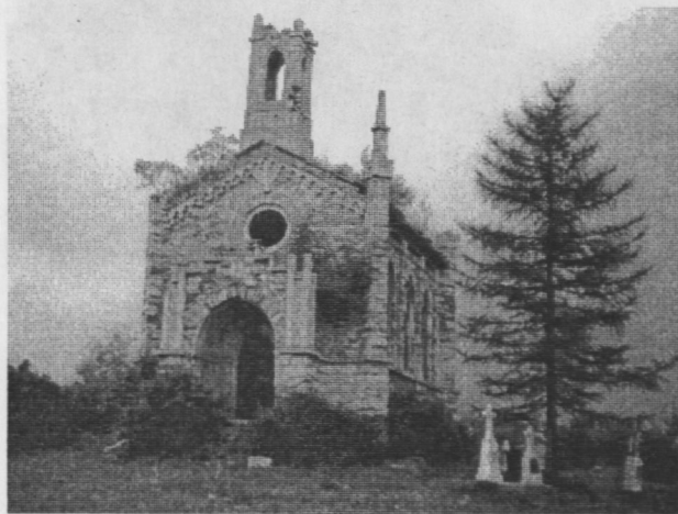
4. Jazłowiec (Ukraina), kaplica cmentarna rodziny Błażowskich zbudowana ok. poł. XIX w., widok ogólny.
