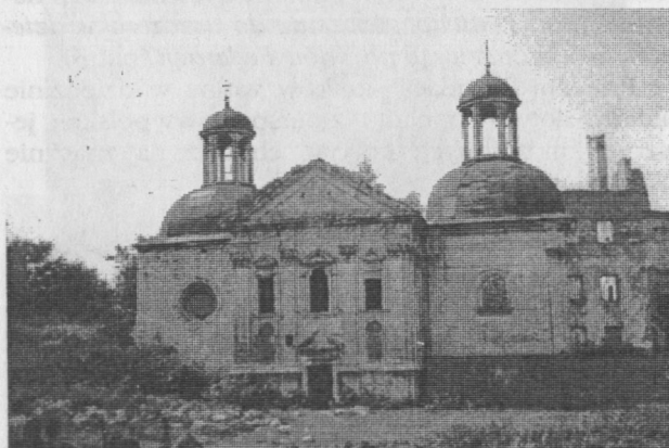
5. Brzeżany (Ukraina), obecnie Berezany, kaplica zamkowa p.w. Trójcy Świętej, widok ogólny.
