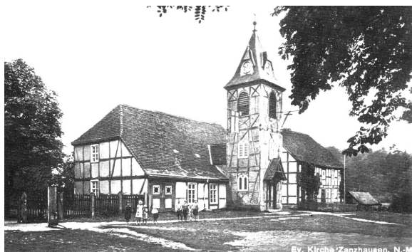
Kościół i zabudowania administracji kuźnicy w Santocznice na przełomie XIX i XX wieku
