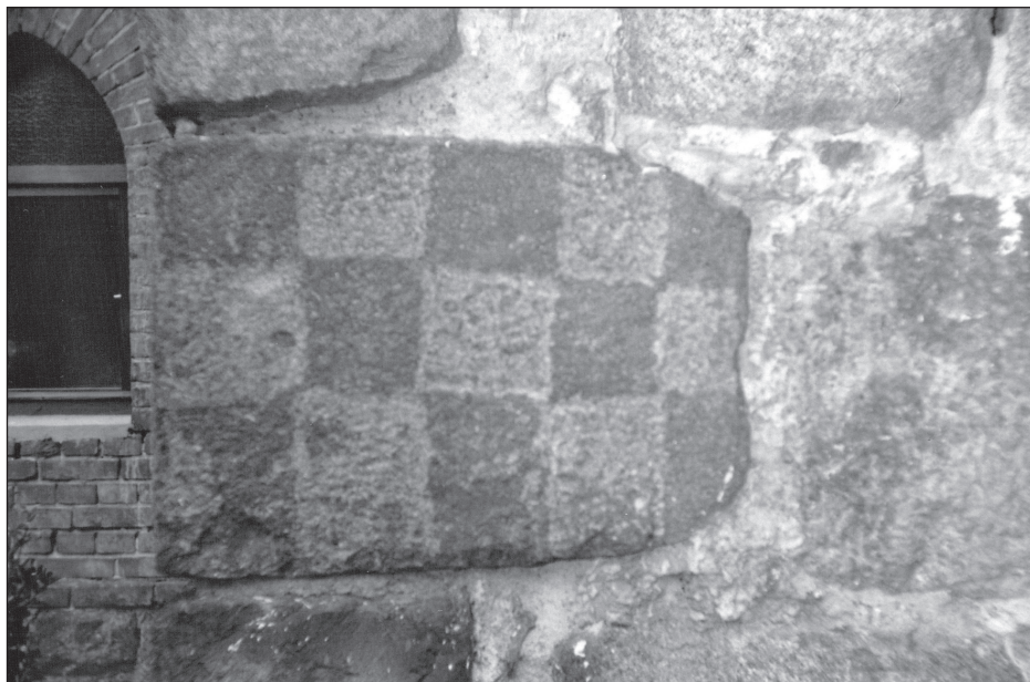
Ryc. 24 Hönow – szachownica z południowo-zachodniego narożnika wieży (stan 1 VII 2005).
