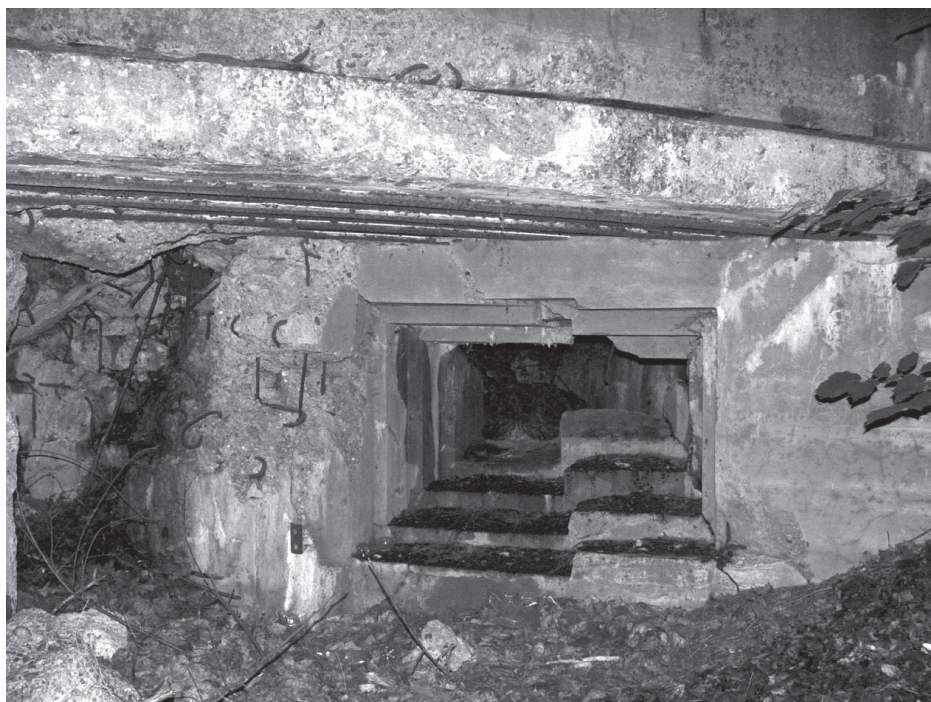
W obiektach typu B1-22 wejścia do obiektu broniono z flanki z płytą 422P01 (V.D. 2). (zdz. J. Wajda)
