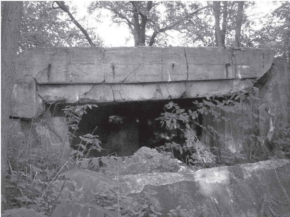
Czoło obiektu V.D. 5 bez płyty pancernej 7P7. (zdj. K. Michalak)
