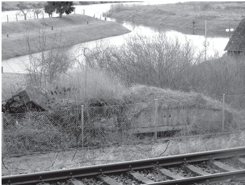
Obiekt V.D. 9 przy linii kolejowej Gorzów-Krzyż. (zdj. K. Michalak)
