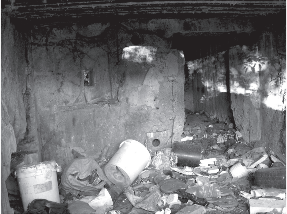
Zaśmiecone wnętrze tego samego obiektu. Widać po lewej stronie usunięty pancerny wejścia 48P8. (zdj. K. Michalak)
