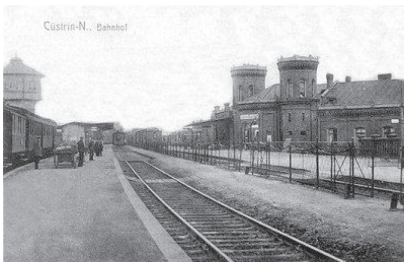
Kostrzyn, dworzec kolejowy (fot. Muzeum Architektury Politechniki Berlińskiej)
