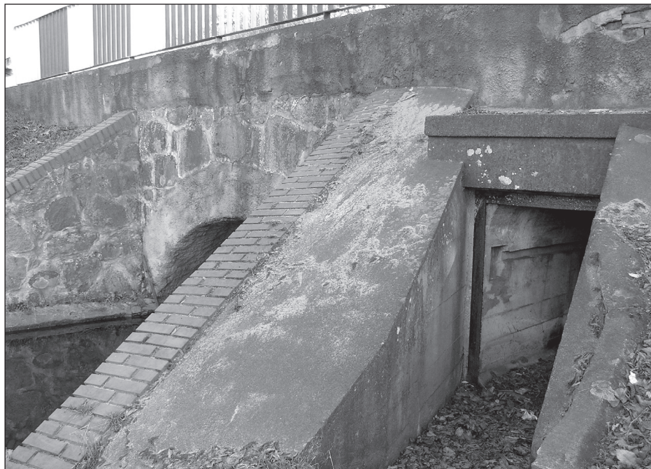
Wejście do chodnika minerskiego przepustu w Zdroisku. Fot. K. Michalak 2011
