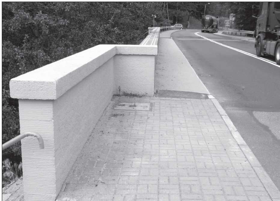
Przyciółek wschodni mostu w Starym Osiecznie z widoczną klapą-zamknięciem chodnika minerskiego. Fot. G. Urbanek 2011
