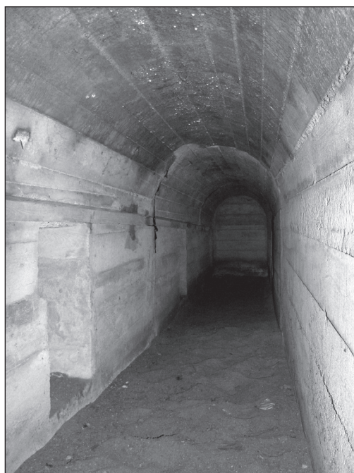
Galeria minerska przepustu w Zdroisku. Fot. G. Urbanek 2011
