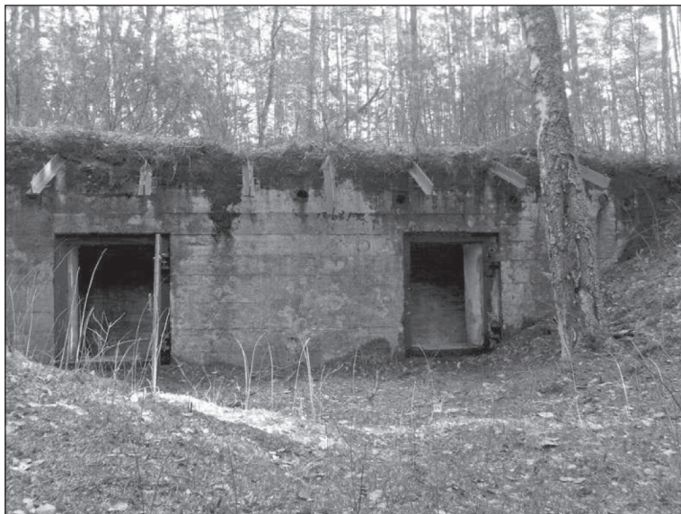
Fot. 4. Elewacja wejściowa schronu biernego z Pustelini (5/1). Fot. K. Michalak, 2011.
