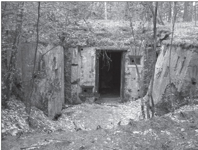
Fot. 7. Widok na wysadzoną izbę bojową schronu odporności B1 (8/3).
