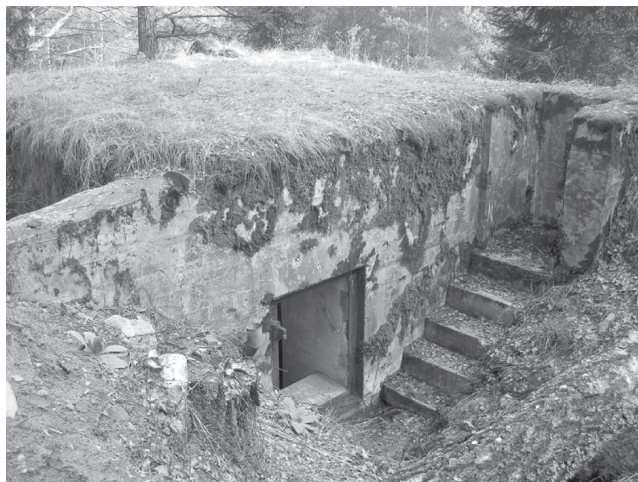
Fot. 3. Odslonięte stanowisko obserwacyjne przy schronie bojowym odporności B1 (2/11). Fot. J. Wajda, 2011.
