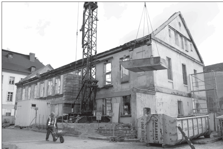
Fot. 1. Gorzów Wlkp., ul. Teatralna 25, budynek c. Remont budynku, fot. M. Pytlak.
