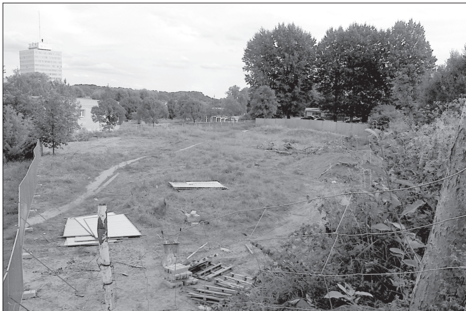
8 sierpnia 2011 – początek budowy
