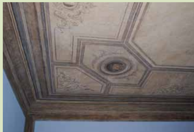
Wnętrze pałacu w Sannikach – stan po konserwacji.
