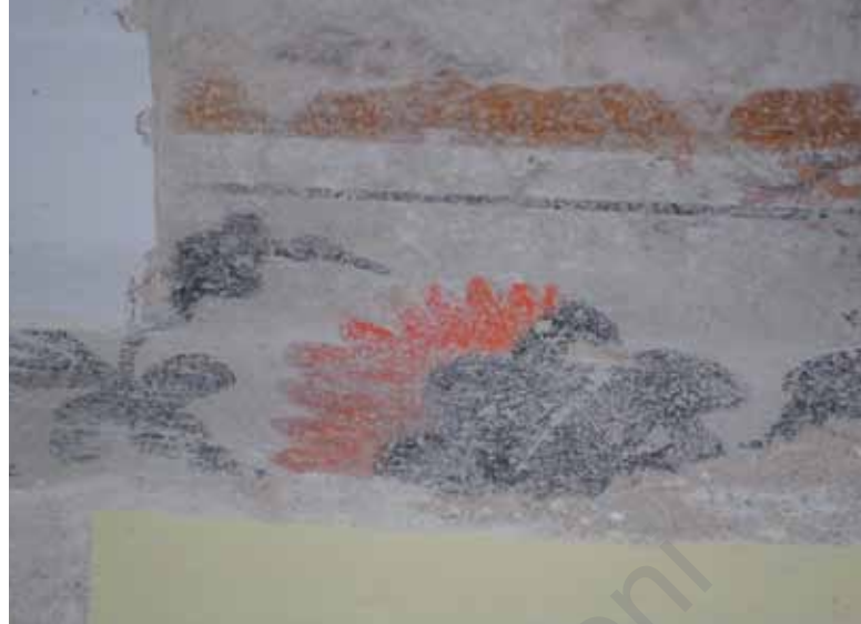
Fragment polichromii malarskiej 1. fazy pałacu – stan przed konserwacją; fot. autorki.
