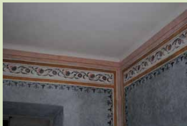
Wnętrze pałacu w Sannikach – stan po konserwacji.
