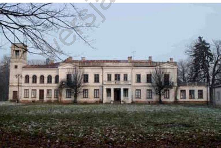
Elewacja frontowa pałacu – styczeń 2011; fot. autorki.
