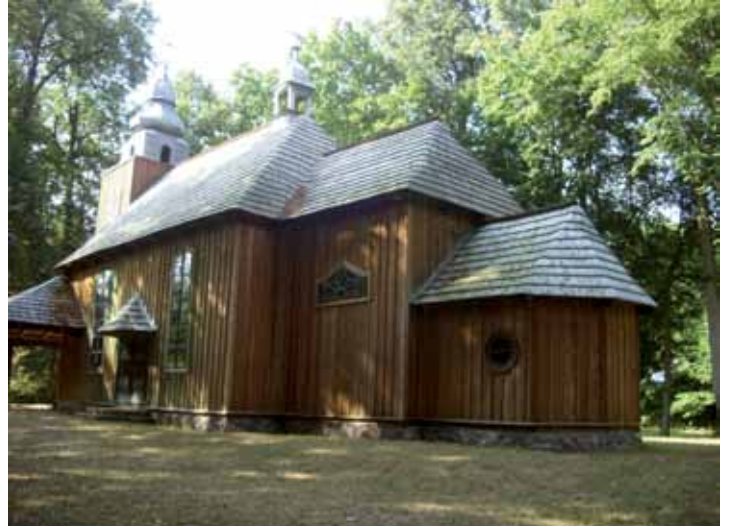
Widok kościoła od strony zakrystii i prezbiterium.
