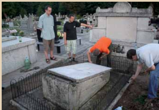
Wstępna renowacja nagrobka Kajetana Balińskiego; fot. A. D. Kotkiewicz.
