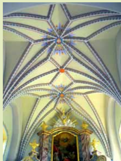
Kościół w Miszewie Murowanym, sklepienie prezbiterium, 2013 r.; fot. A. B. Muszalski.
