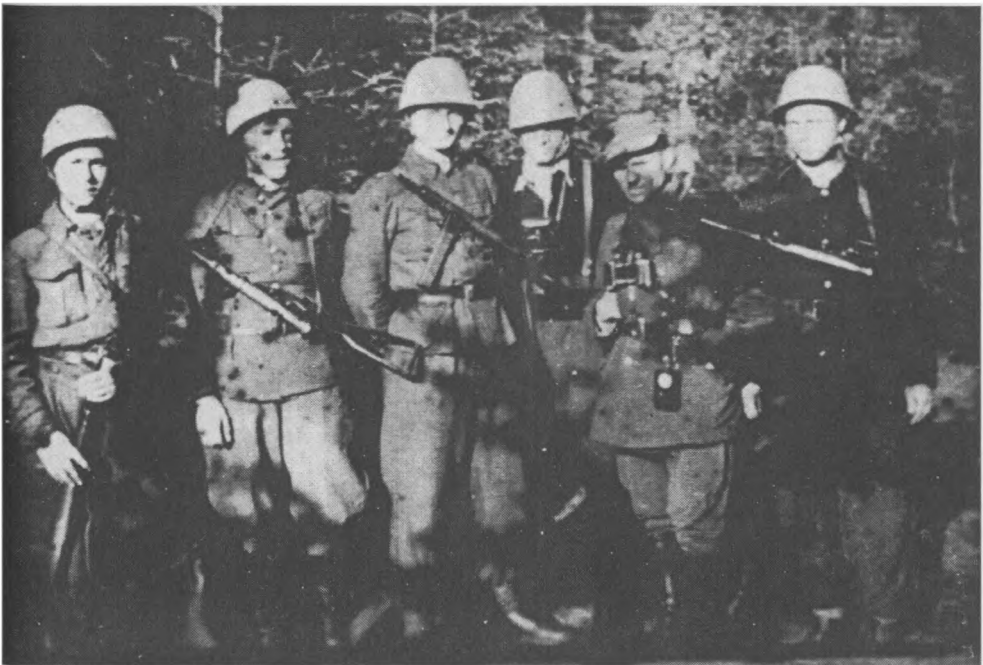
Patrol I bat 27 pp AK na koncentracji pod Przysuchą
