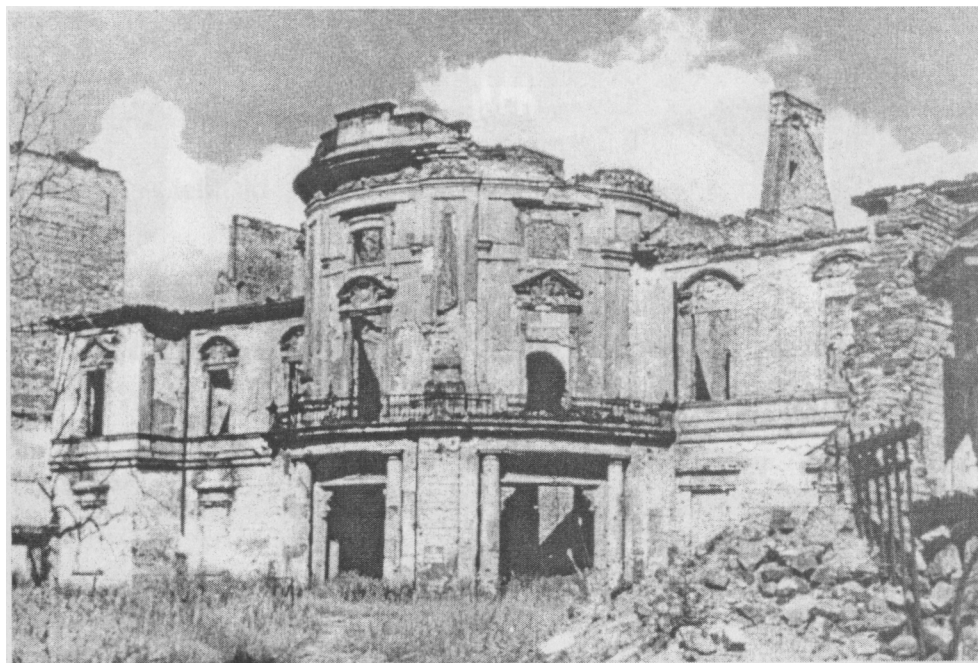
Ruiny Pałacu Radziwiłłów po Powstaniu Warszawskim, fot. Dąbrowiecki, ok. 1946, MHW
