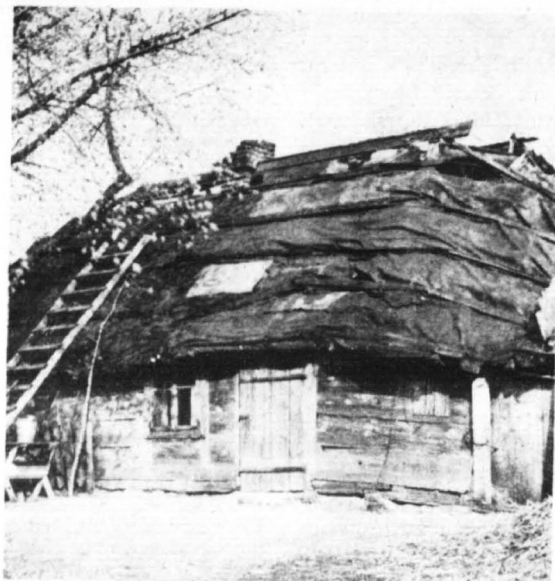
Dom mieszkalny Stanisława Garwackiego o ciekawej konstrukcji, który wkrótce poddany zostanie remontowi.
