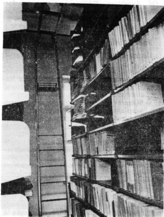
Fragment magazynów Biblioteki. Nietypowe metalowe regały (prawie 4 metry wysokości) wykonały Zakłady Stolarki Budowlanej „STOLBUD”, a 25 samojezdnych drabin wykonali w Fabryce Maszyn Zniwanych w Płocku członkowie Stowarzyszenia Inżynierów Mechaników Polskich. Długość zainstalowanych półek (tącznie z typem międzynarodowym — 2 m wysokości) wynosi 1 202 metry bieżące
