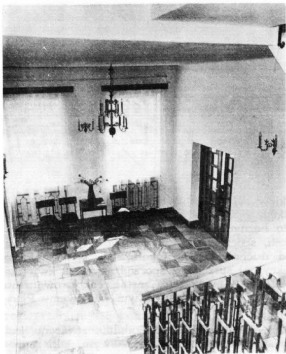
Hall I piętra. Na prawo wejście do czytelnictwa -pracowni
