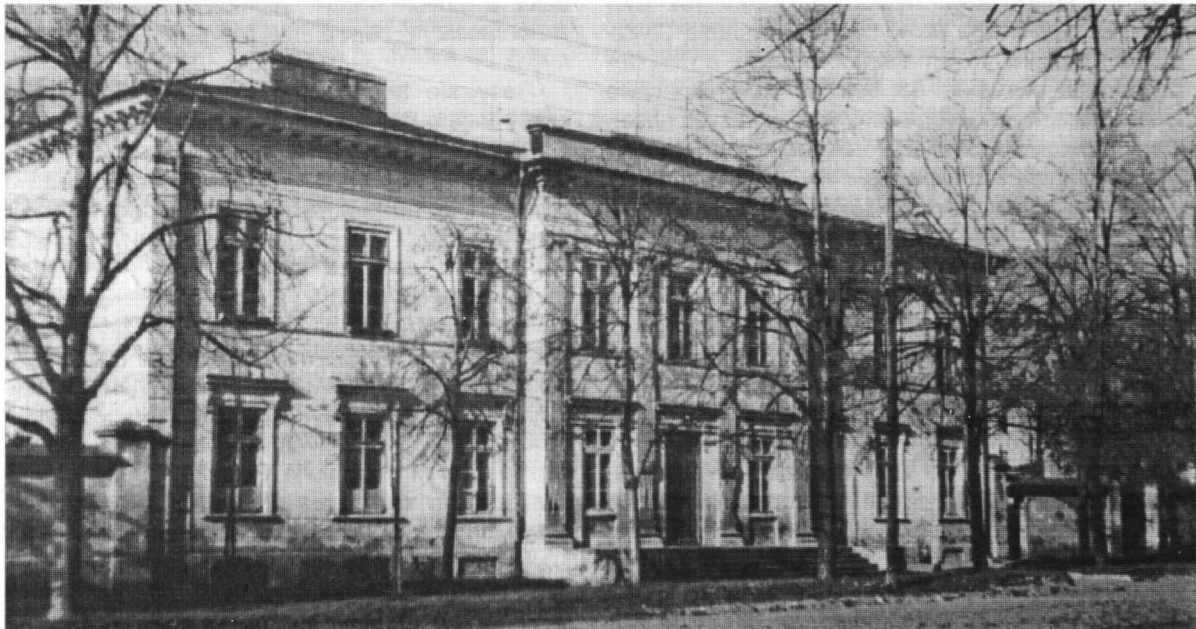
Budynek Szkoły Pedagogicznej w Łęczycy (z końca XVIII w.)
