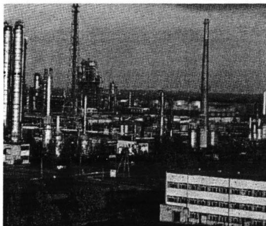
Sumaryczna zdolność produkcyjna kotłów utylizacyjnych wynosi około 500 t/h.
