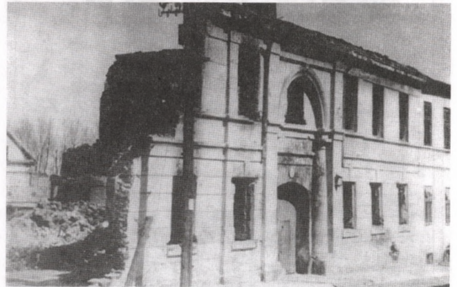
Fot. 4. Zburzony dom na obecnym narożniku ulic Sienkiewicza i 18-go Stycznia
