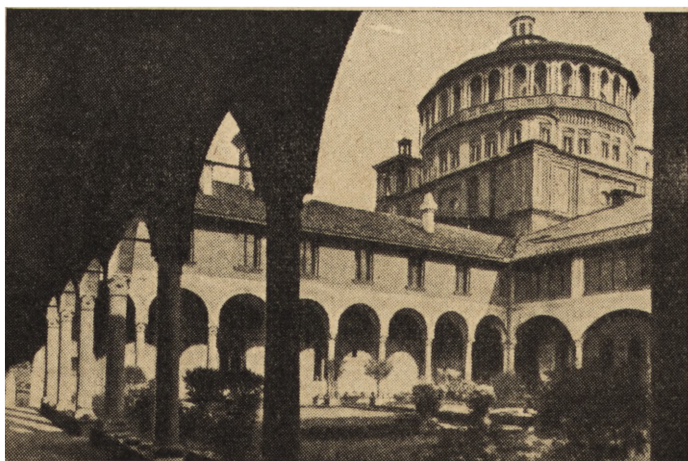
Ryc. 46. Kościół Santa Maria delle Grazie w Mediolanie przed zniszczeniem.
