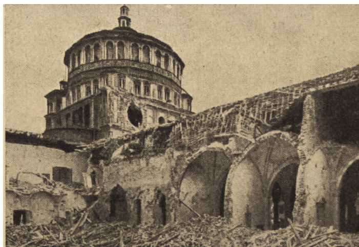
Ryc. 47. Kościół Santa Maria delle Grazie w Mediolanie po zniszczeniu.
