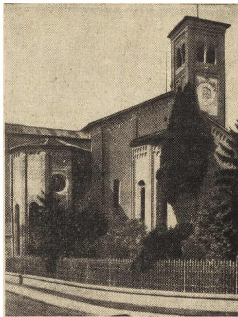
Ryc. 50. Kościół Eremitani w Padwie przed zniszczeniem.
