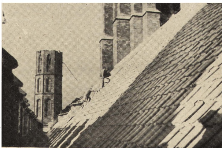
Ryc. 33. Gdańsk, kościół N. M. P., krycie dachu (fot. K. Lelewicz).
