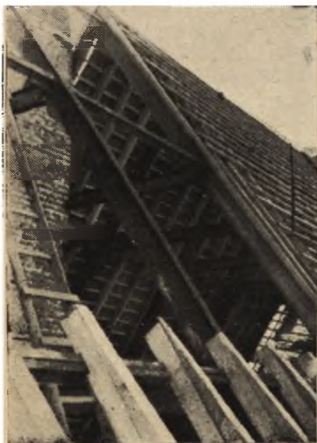
Ryc. 37. Gdańsk, ratusz prawomiejski, więźba dachowa o żelaznej konstrukcji w połączeniu z zastosowaniem drewnianych krokwi ( fol. J. Cofta ).
