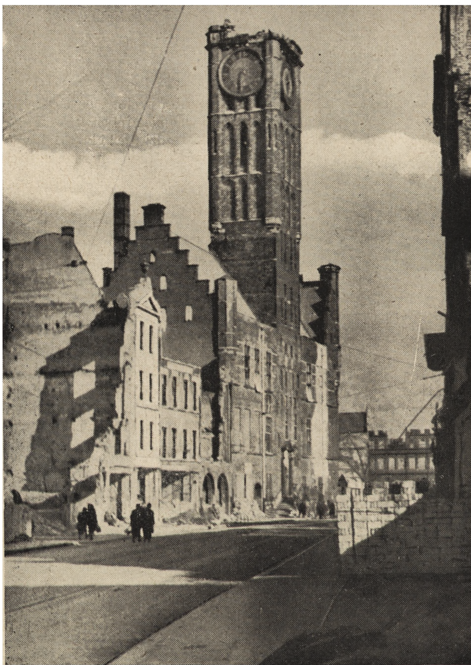
Ryc. 38. Gdańsk, ratusz prawomiejski, widok na odbudowany dach i uzupełnioną wyrwę w fasadzie (fot. K. Lelewicz).
