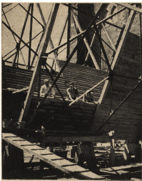
Ryc. 36. Gdańsk, kościół N. M. P., układanie dyl żelbetowych pod dachówkę ( fol. K. Lelewicz ).
