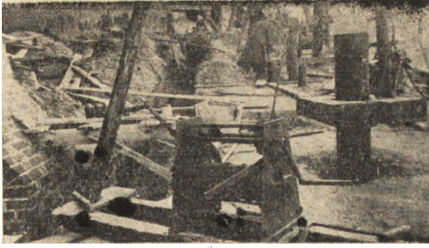
Ryc. 55. Widok górnych końców rur zapuszczonych w teren wokół murów kościoła.
