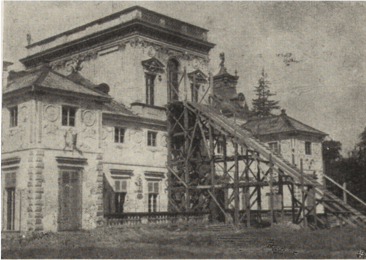
Ryc. 16. Wilanów — pałac. Rusztowanie do wielkiej sali.
