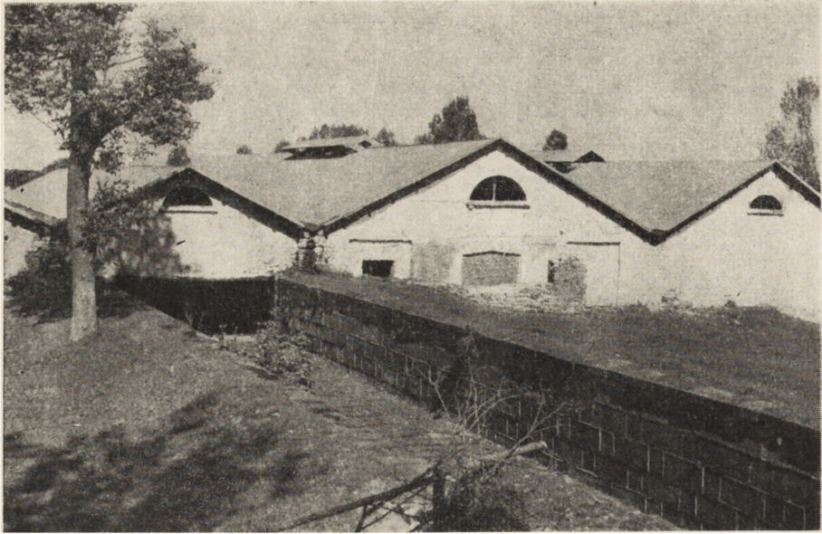
Ryc. 98. Sielc — kanał wlotowy i hala fabryczna.
