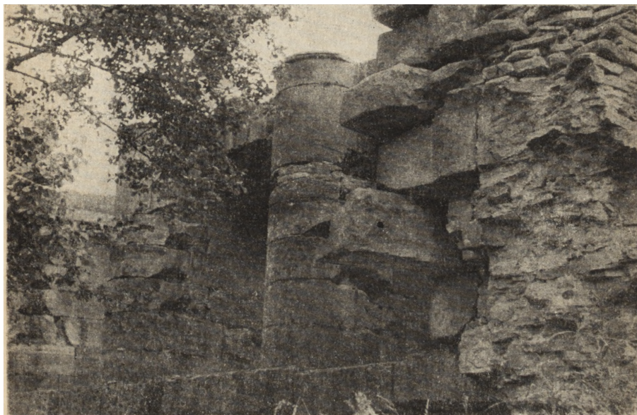
Ryc. 95. Brody — walcownia. Fragment przepustu na Kamiennej. fol. Krygier
