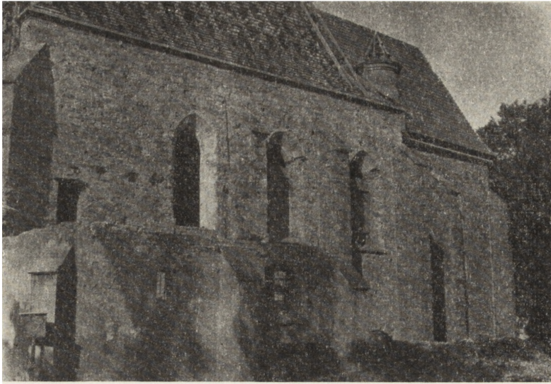
Ryc. 122. Jasio --- kościół w czasie robót rekonstrukcyjnych. Stan z r. 1949. fot. Ross
