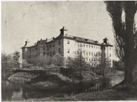
Ryc. 184. Rydzyna, pow. Leszno — widok pałacu z r. 1944 przed zniszczeniem.
