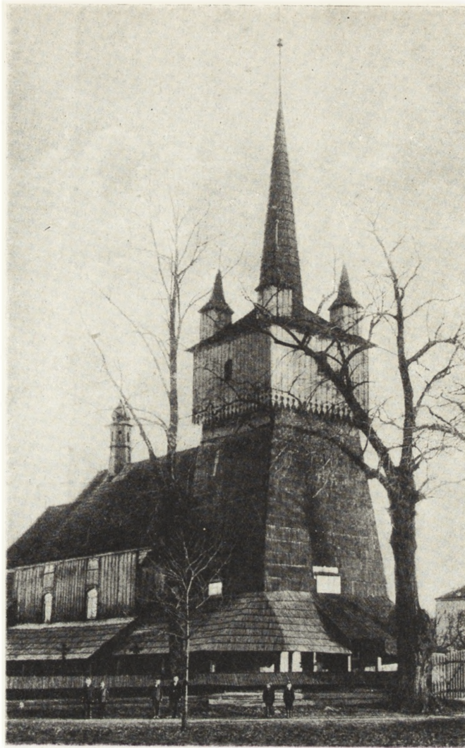
Ryc. 49. Kościół w Komorowicach. Widok od północno-zachodu. Fotografia z r. 1931.
