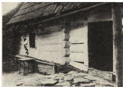
Ryc. 118. Frampol, pow. Biłgoraj — dom przy ul. Butlerowskiej 12 z r. 1804; fragment ściany wschodniej.
