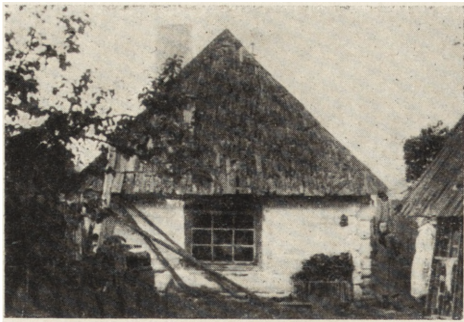
Ryc. 117. Frampol, pow. Biłgoraj — dom przy ul. Przemysłowej 7 z r. 1812; widok od południa.
