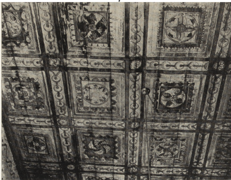
Ryc. 161. Fragment polichromii stropu nawy.
