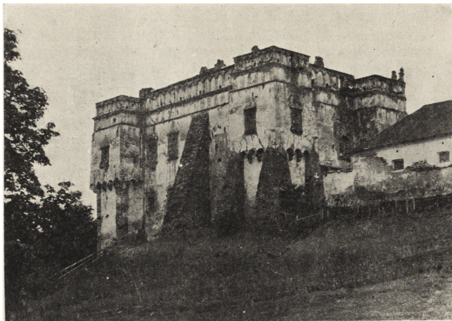
Ryc. 89. Szymbark, dwór obronny przypuszczalnie z lat 1585—1590 (przed restauracją), z basztami alkierzowymi na narożnikach.
