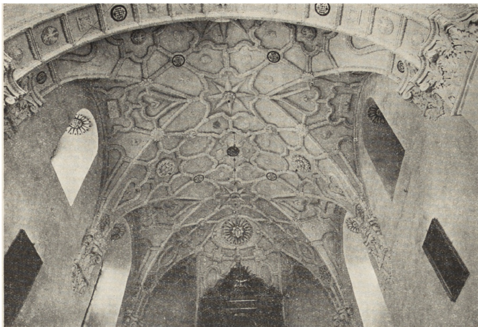
Ryc. 91. Czemierniki, sklepienie kościoła parafialnego z r. 1614, z geometrycznymi sztukateriami późnorenesansowymi.
