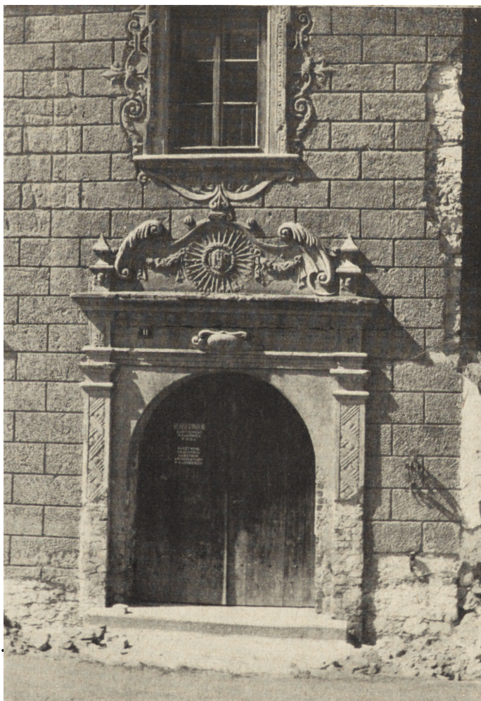
Ryc. 177. Kamienica Celejowska — portal wykonany w narzucie z zaprawy wapiennej.
