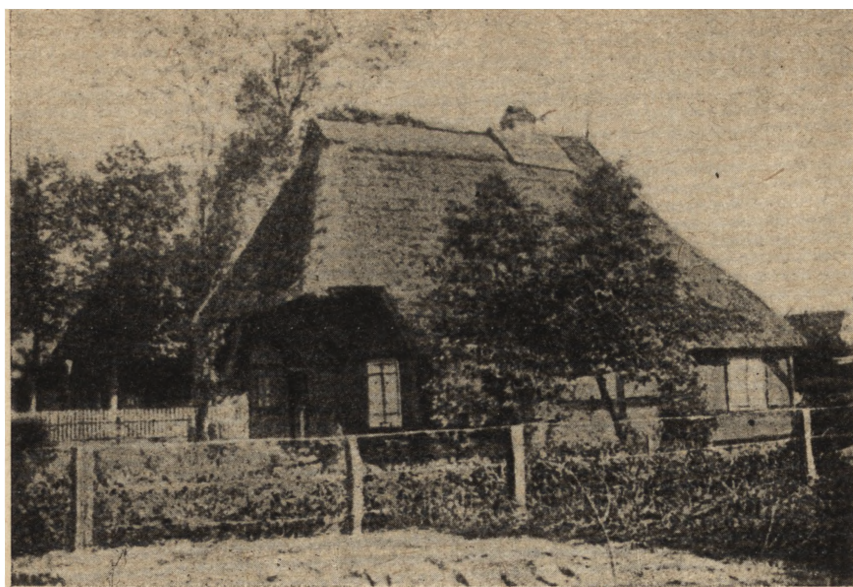
Ryc. 260. Chata w Meklemburgii (Wustrow). Słupy podcieniowe znikły, nadwieszony dach podtrzymują belki.
